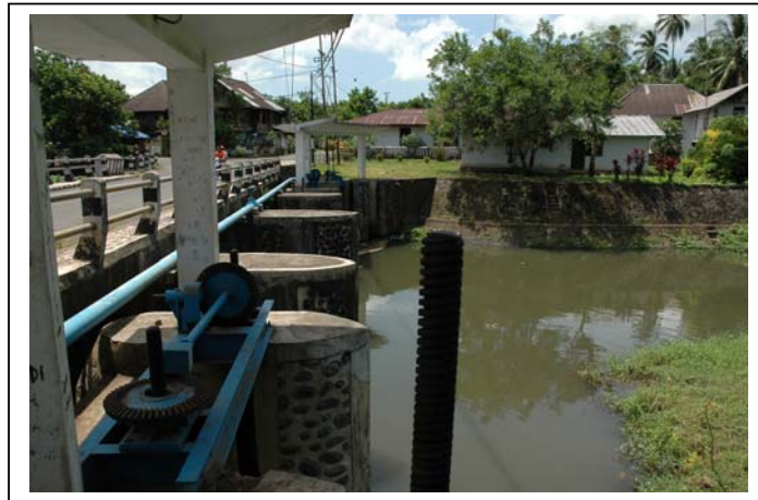
Gambar 3.20. Bendungan Sungai Talawaan
