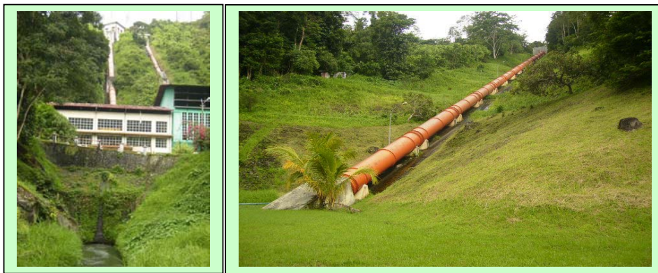
Gambar 3.1. Alur sungai yang dialirkan melalui pipa terowongan PLTA
